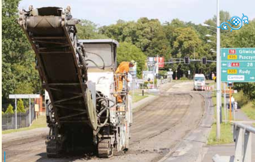
Roboty na ul. Kotucha rozpoczęły się od sfrezowania starej nawierzchni
