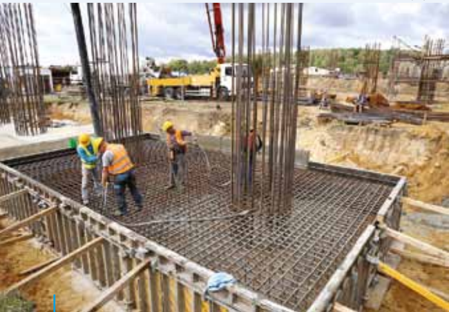
Na przełomie kwietnia i maja rozpoczęła się budowa rybnickiego odcinka drogi regionalnej Racibórz – Pszczyzna. To największa inwestycja drogowa w historii Rybnika
