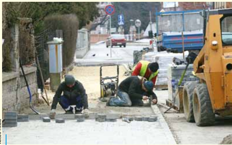
Pomimo zimowych warunków kontynuowane były roboty chodnikowe, m.in. na ul. Na Górze
