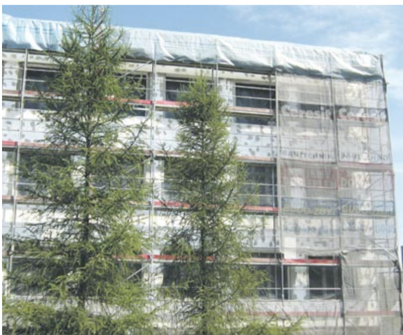
Termomodernizacja była możliwa dzięki środkom z Unii Europejskiej
